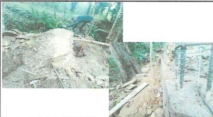
FOTO 1: DEMOLICIÓN DE MURO DE PIEDRA EXISTENTE EN MAL ESTADO Y FUNDICIÓN DE MURO CONTENCIÓN
