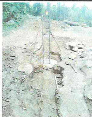
FOTO 3: PREPARACIÓN DE BASES PARA COLUMNAS DE CONCRETO DEL PORTÓN
