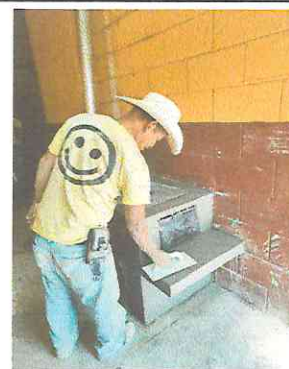
FOTO 4: FABRICACIÓN DE ESTUFA CON CHIMENEA
