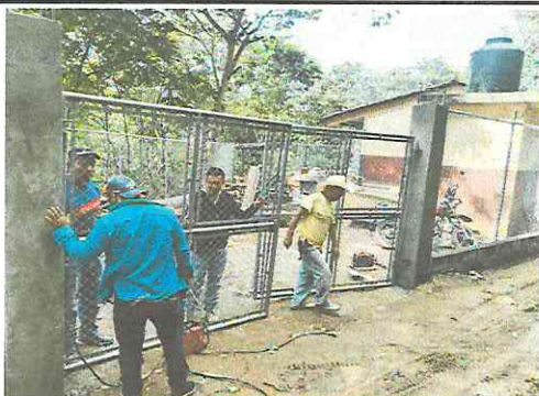
FOTO 5: INSTALACIÓN DE PORTÓN DE MALLA GALVANIZADA
