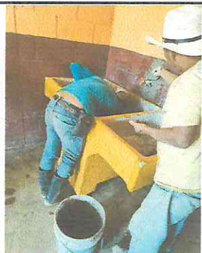
FOTO 6: REPARACIÓN DE ACCESORIOS DE SANITARIOS EN SERVICIOS SANITARIOS E INSTALACIÓN DE PILA EN COCINA
