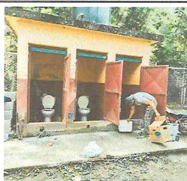
FOTO 6: REPARACIÓN DE ACCESORIOS DE SANITARIOS EN SERVICIOS SANITARIOS E INSTALACIÓN DE PILA EN COCINA
