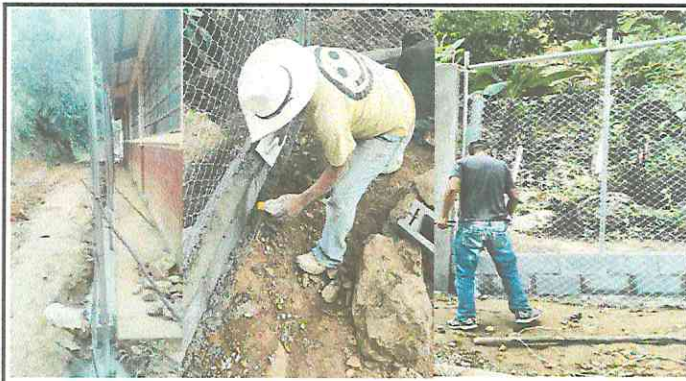
FOTO 2: LEVANTADO DE BLOCK, INSTALACIÓN DE TUBOS Y MALLA GALVANIZADA
